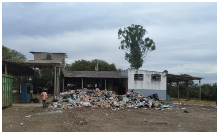
Figura 1: Área de Transbordo no município Fonte: Autores (2023)
